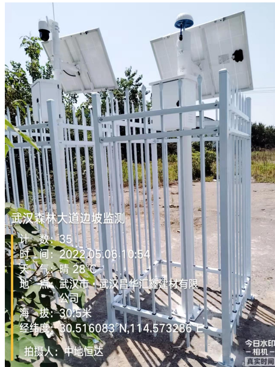
GNSS 监测站-安装现场实物图
